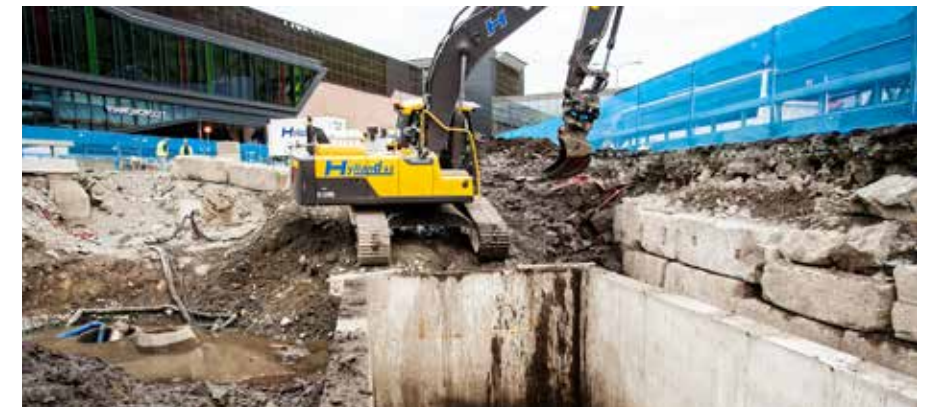
Ved Loddefjord måtte de lage en egen settekasse i betong til pumpestasjonen
